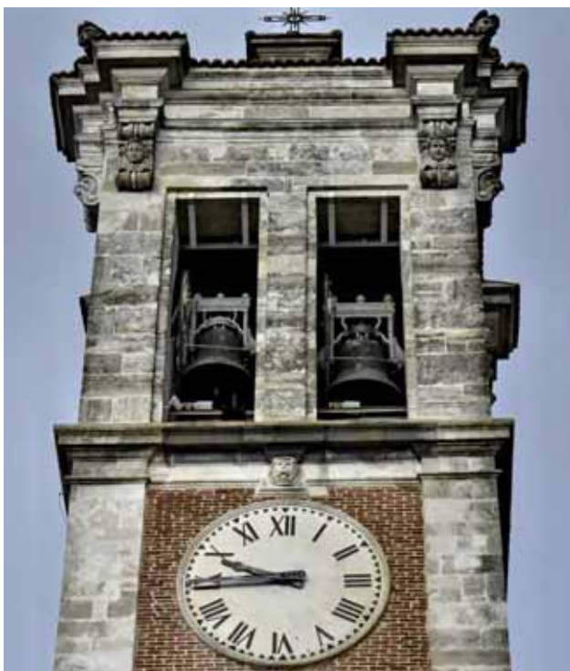
Cella campanaria del campanile del Sacro Monte
